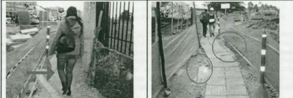
Senderos estrechos por los cuales solo se puede transitar de manera incomoda una persona atendiendo contra el ancho mínimo en función de la alta demanda peatonal del sector.
